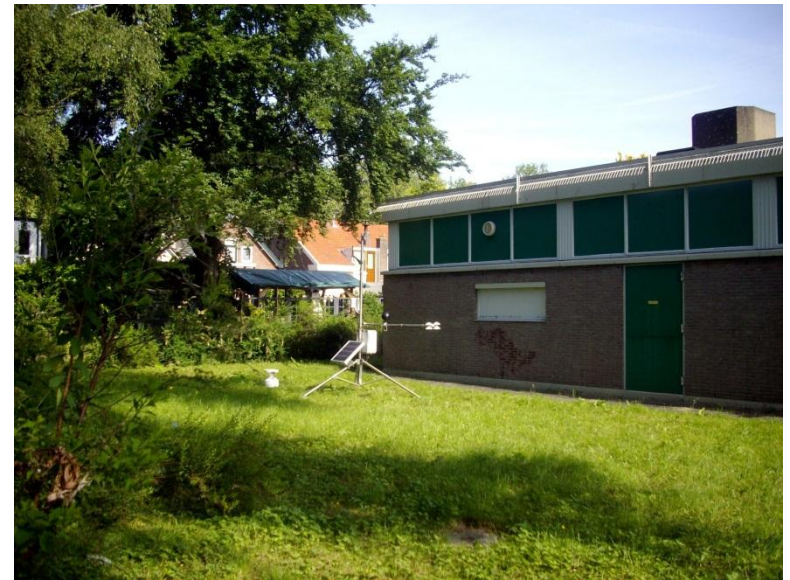
Rioolgemaal (Bolnes, gemaal)
