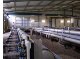
Nordkanal MBR, Germany
