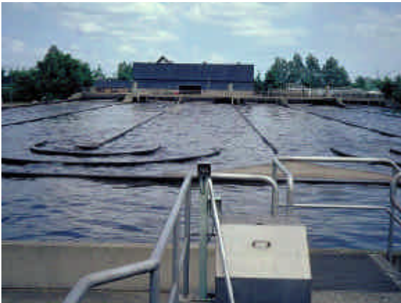
Figuur 11 - Actief-slibstelsel als omloopsysteem
