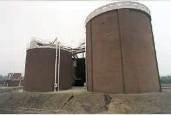
Figuur 17 - Intensief gemengde gistingstank
