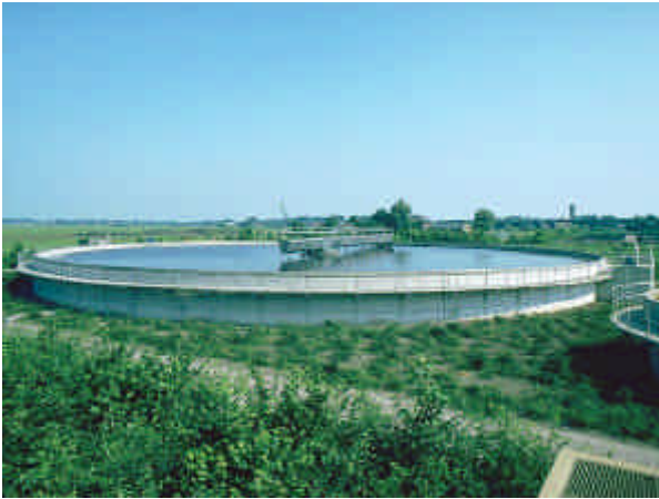
Figuur 8 - Voorbezinktank
