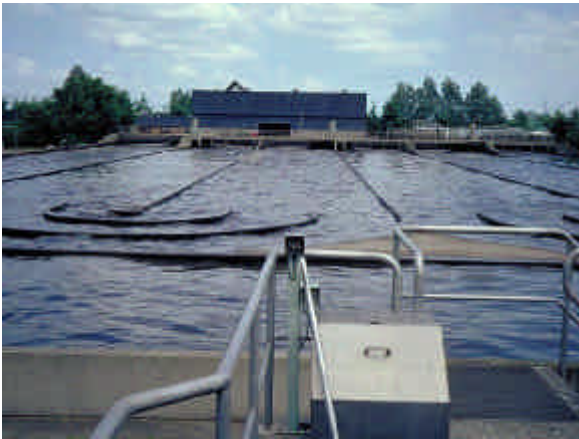
Figuur 11 - Actief-slibstelsel als omloopsysteem
