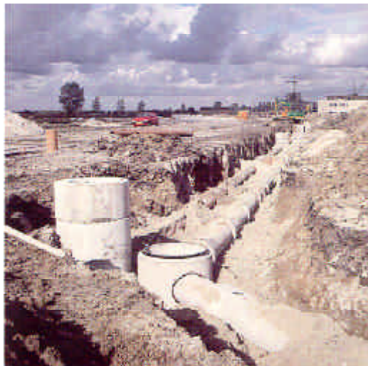
Figuur 9 - Aanleg van buizen en put.
