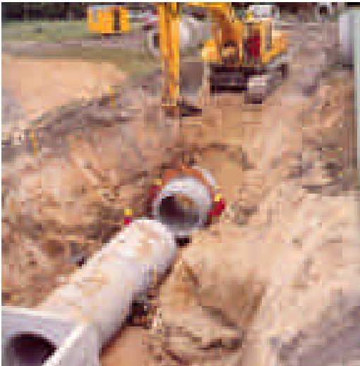
Figuur 10 - Aanleggen van riolering
