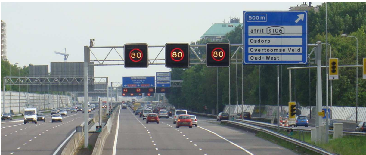
FIGUUR 2.1: HET RIJSTROOKSIGNALERINGSSYSTEEM (MOTORWAY TRAFFIC MANAGEMENT: MTM)
