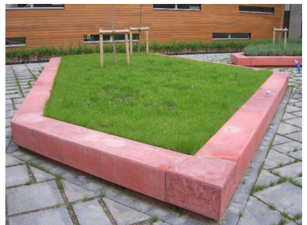
Figuur 11: Gekleurd beton
