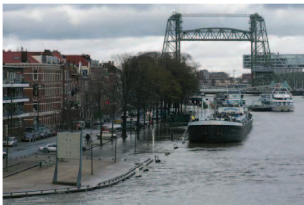
4. Noordereiland Rotterdam tijdens hoog water
