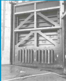
Puntdeur – staal (steel mitre gate)
