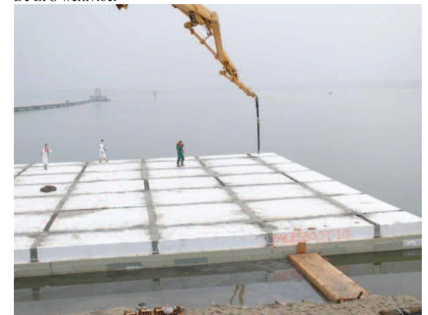
Het storten van de balken
