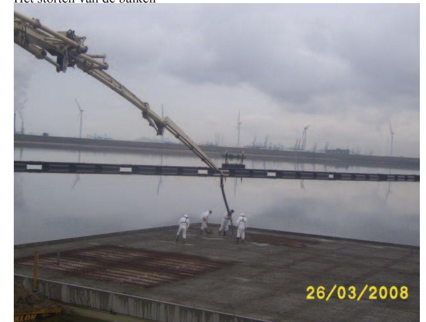
Het storten van de vloer
