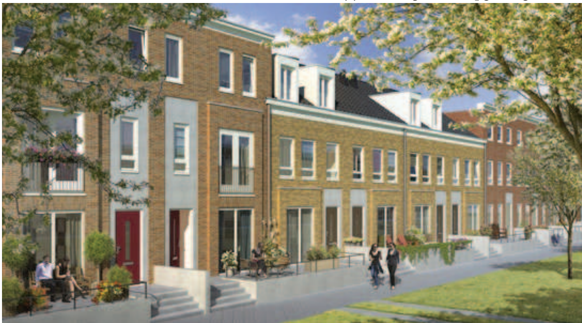
Rijteswoningen met opgehoogde vloer
