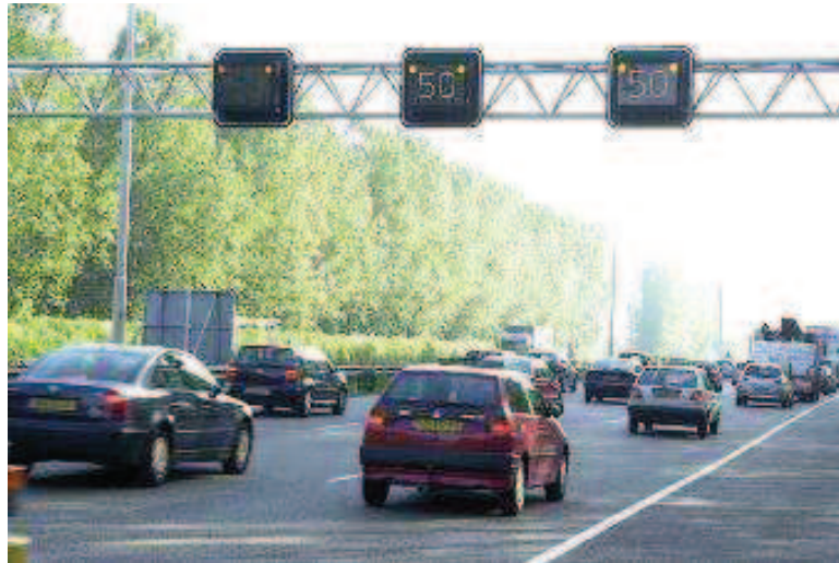
FIGUUR 2.1: HET RIJSTROOKSIGNALERINGSSYSTEEM (MOTORWAY TRAFFIC MANAGEMENT: MTM) OPERATIONEEL OP DE NEDERLANDSE SNELWEGEN SINDS MID-JAREN 80. HET SYSTEEM DETECTEERT FILES, DWZ EEN VERLAGING IN DE GEMIDDELDE SNELHEID EN WAARSCHUWT NADERENDE AUTOMOBILISTEN. HET SYSTEEM WAS EN IS ZEER SUCCESVOL: HET AANTAL ONGELUKKEN NAM AF MET CIRCA 25%, HET AANTAL DODELIJKE KOP-STAART BOTSINGEN DAALDE NOG VEEL STERKER.
