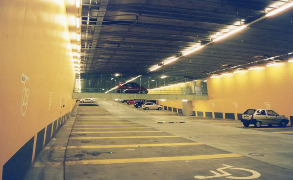
Arnhem Centraal: Parking Sectie Ondergronds Bouwen, TU Delft
