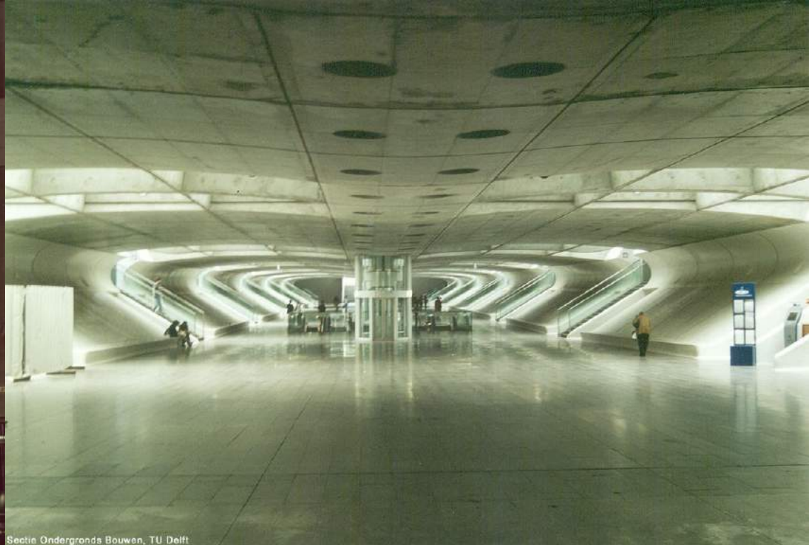
Sectie Ondergronds Bouwen, TU Delft
