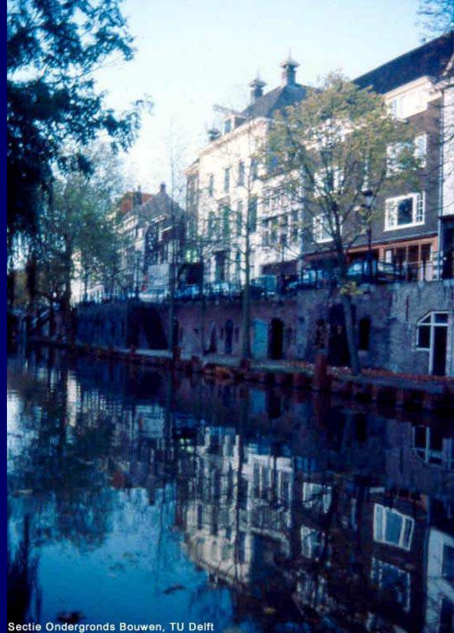
Sectie Ondergronds Bouwen, TU Delft
