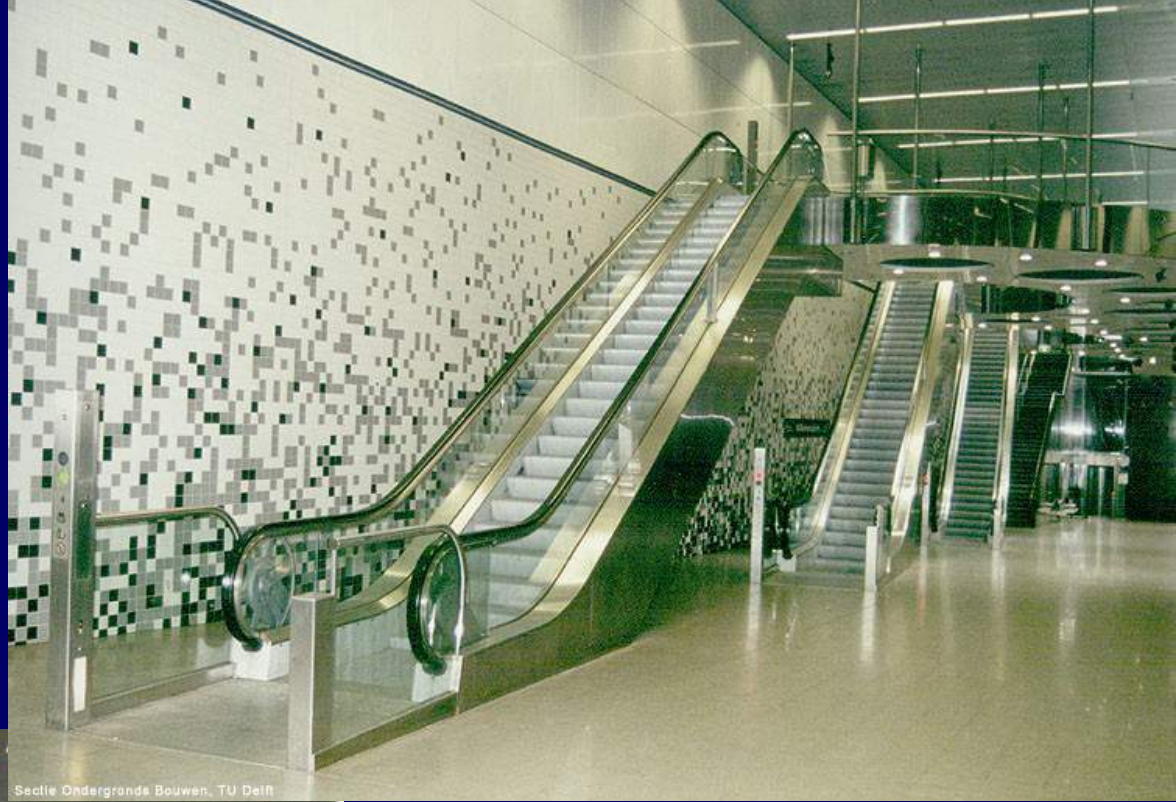
Sectie Ondergronds Bouwen, TU Delft
