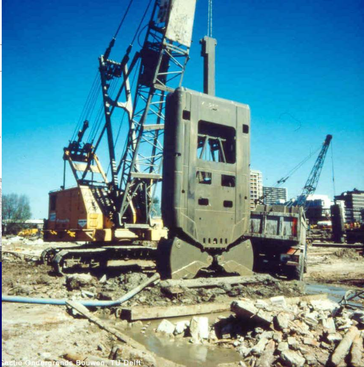
Sectie Ondergronds Bouwen, TU Delft
