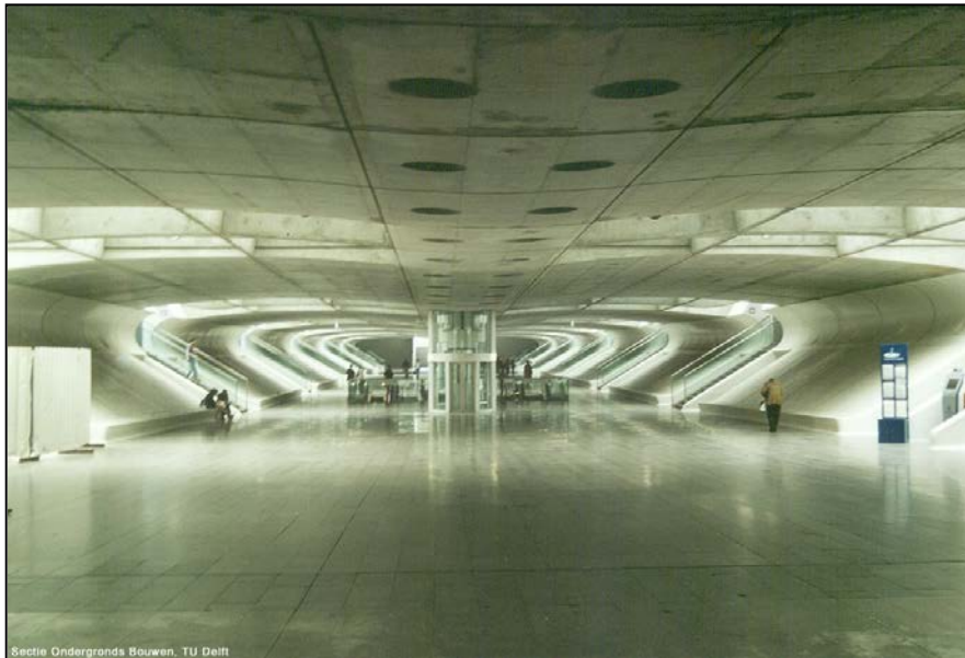
Metro Oriente (EXPO), Lissabon (Calatrava)
