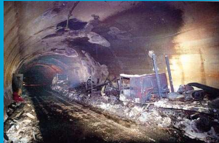
Mont Blanc tunnel
