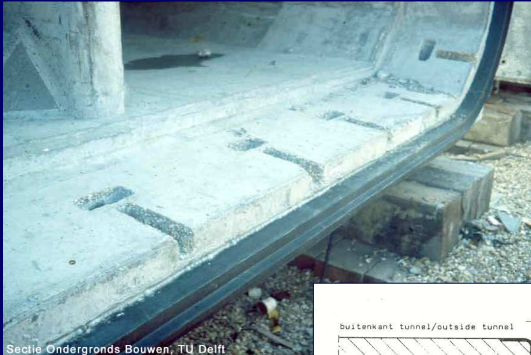
Sectie Ondergronds Bouwen, TU Delft
